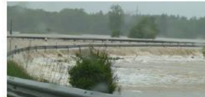
Die A8 wird von der Tiroler Achen überflutet
